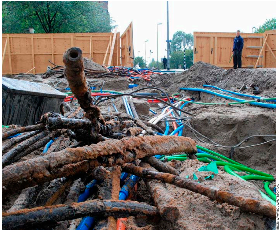
Kabels- en leidingen in het stationsgebied Utrecht.
