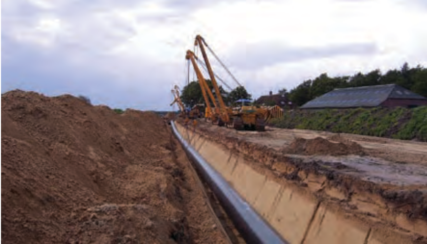
Afb.29 Aanleg van transportgasleiding
