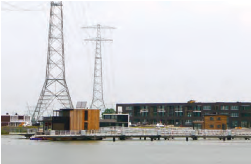
Afb.3 Hoogspanningskabels en stedelijke ontwikkelingen conflicteren
