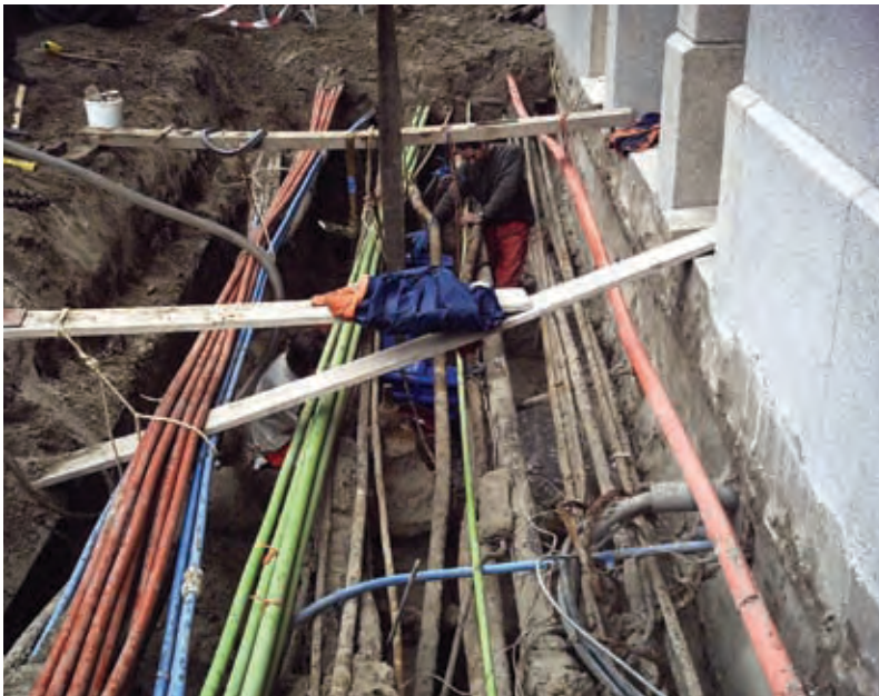
Afb.11 Spaghetti in de ondergrond: werkzaamheden onder bestaande kabels en leidingen.
