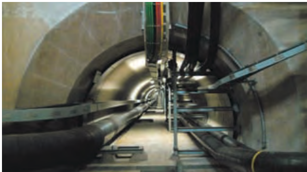
Afb.3 Leidingentunnel Hollandsch Diep
