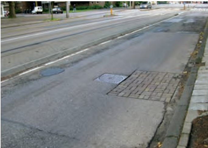
Afb.14 Het wegdek wordt na verloop van tijd een "lappendeken"
