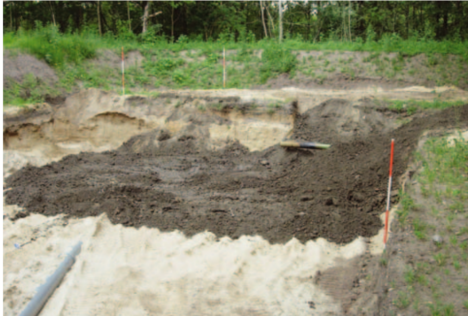
FIGUUR 3. Aanbrengen van een kleilaag in Testveld 1.
