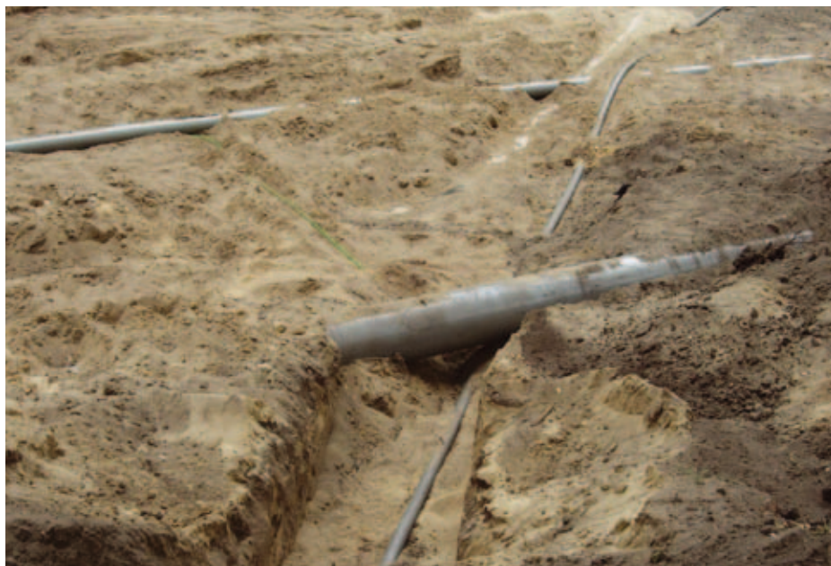
FIGUUR 4. Kruisende kabels en leidingen in Testveld 1.
