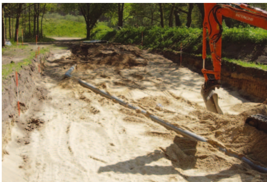
FIGUUR 2. Aanleg van een pvc leiding in Testveld 1.
