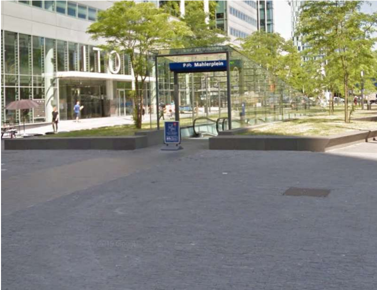
Figuur 31, ingang fietsparkeergarage Mahlerplein
