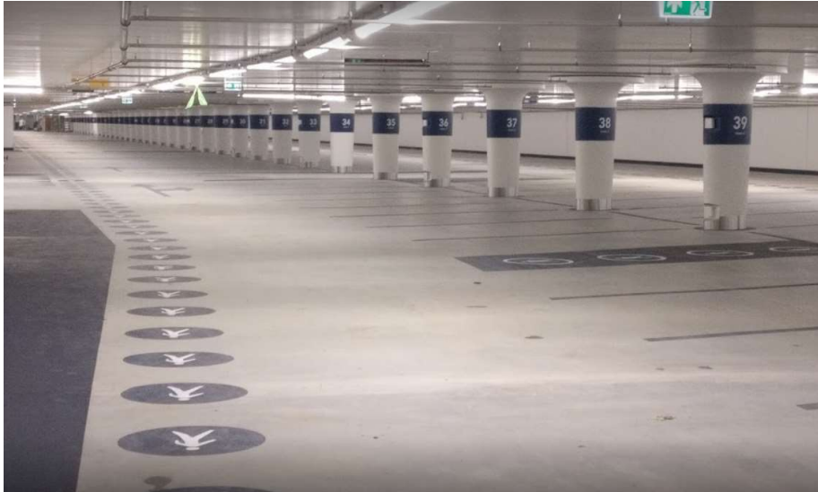
Figuur 28, parkeergarage boerenwetering binnen
