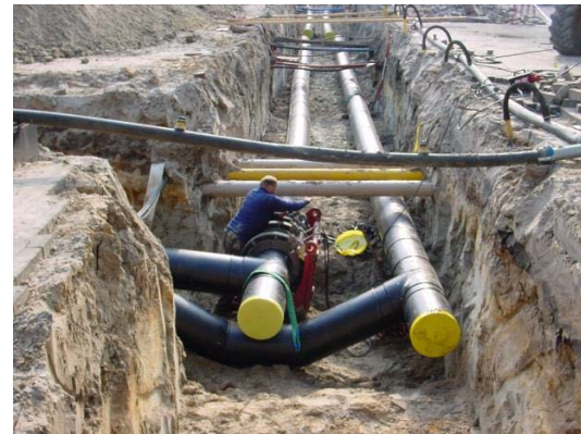
Figuur 39: Ringleidingnet van het WKO-systeem TU Eindhoven (collectief doubletsysteem)
