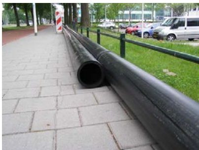
Figuur 35: Twee-pijpen leidingennet Radboud Universiteit (collectief doubletsysteem)
