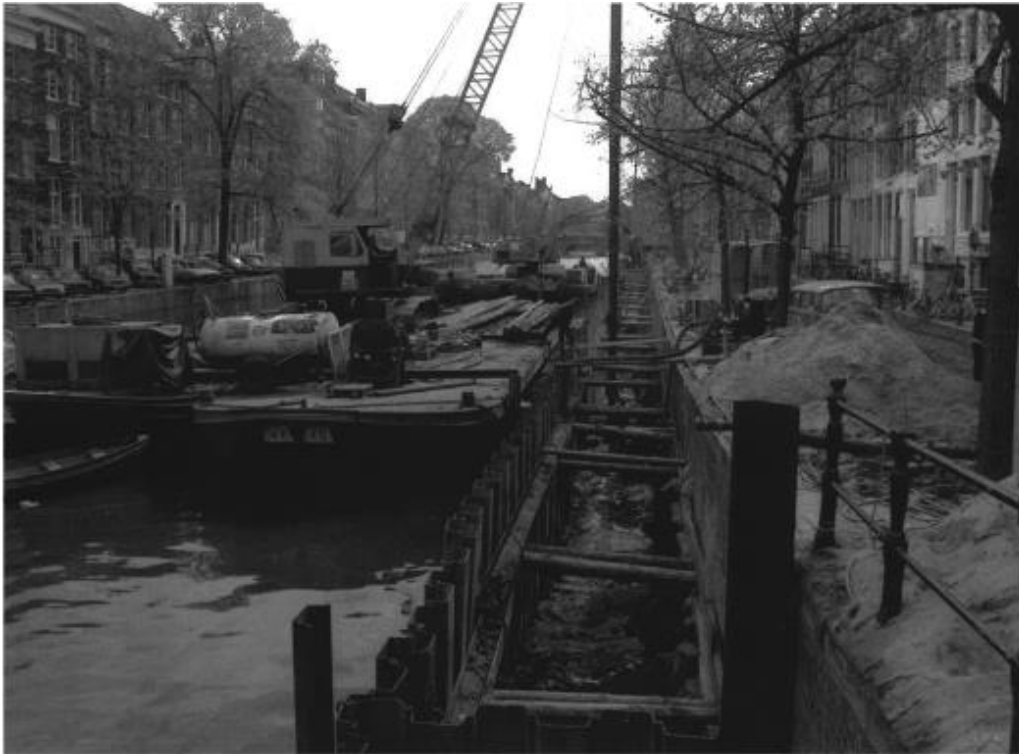
Figuur 77: Aanleg riolering in waterkant grachtengordel Amsterdam
