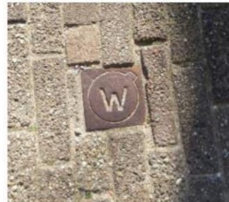
Figuur 23: Drinkwater afsluiters Keizersgracht (bron: Eigen foto)
