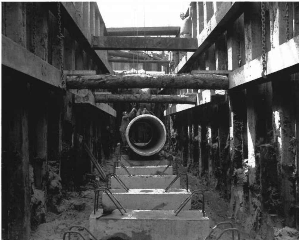
Figuur 78: Aanleg riolering in waterkant grachtengordel Amsterdam
