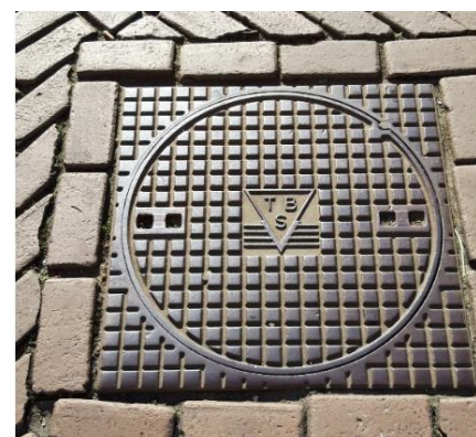
Figuur 15: Putdeksel gemengd rioolstelsel Keizersgracht uitvergroot (bron: Eigen foto)
