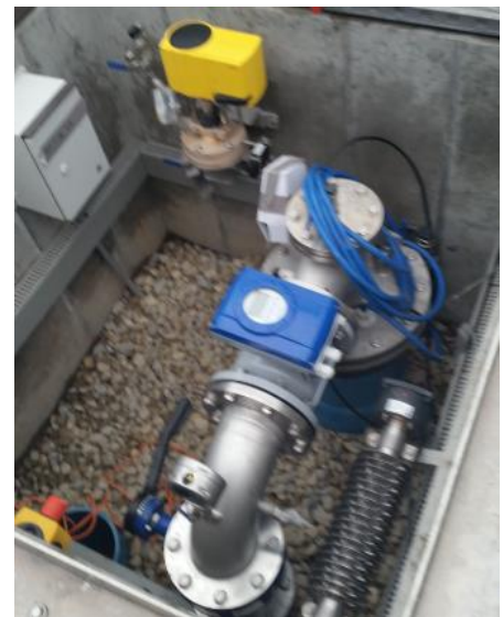
Figuur 63: Inhoud open WKO put (Bron: H.J. Lammers)
