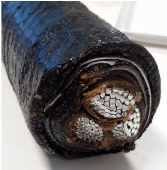
Figuur 36: Oudere middenspanningskabel 3x 150mm (Bron: eigen foto)
