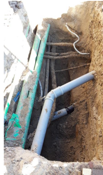
Figuur 12: Kabels en Leidingen in stoep Keizersgracht (Bron: Eigen foto)
