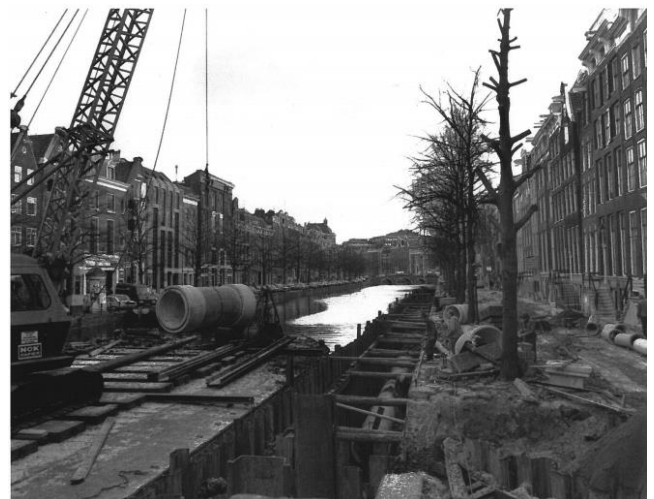
Figuur 17: Aanleg verzamelriool in de waterkant van de gracht
