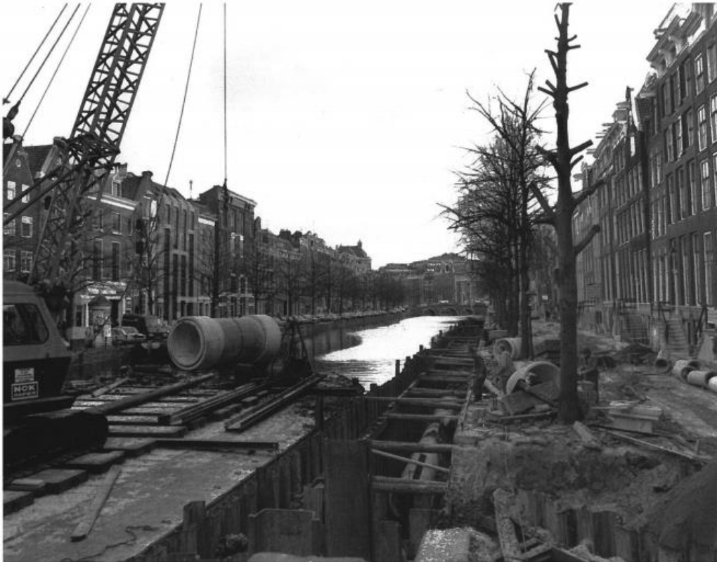
Figuur 79: Aanleg riolering in waterkant grachtengordel Amsterdam
