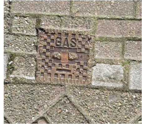
Figuur 19: Gas afsluiting (bron: Eigen foto)
