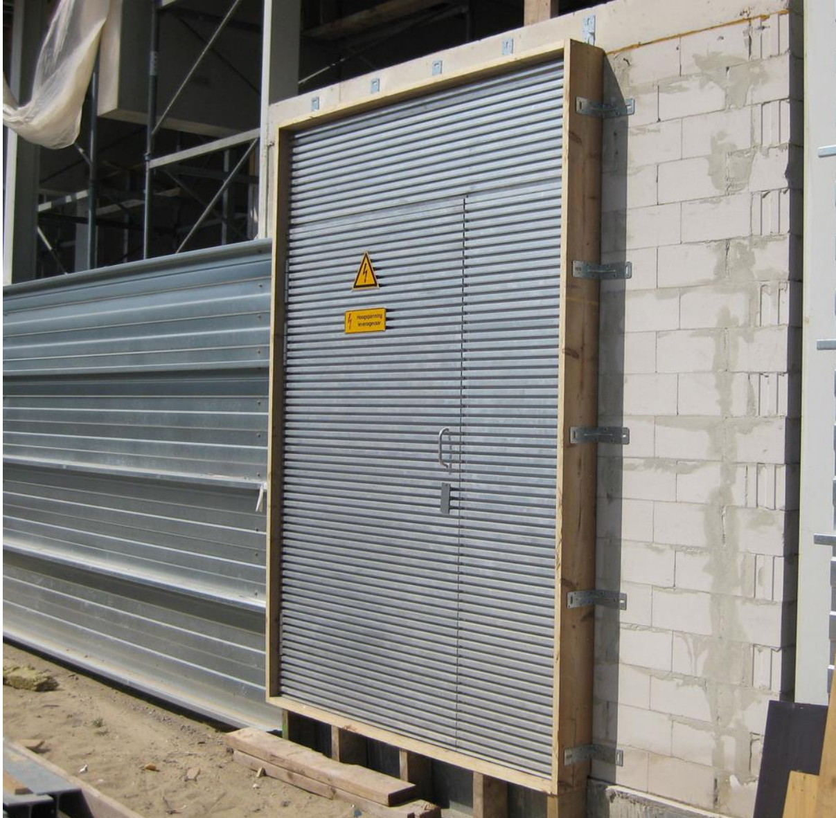
Figuur 31: JAZO-deur, deze standaardoplossing wordt gebruikt voor inpandige algemene voedingspunten
