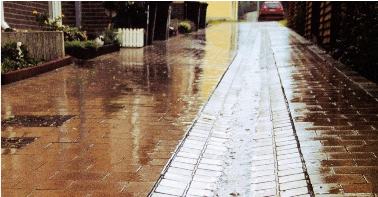
Figuur 27: Een stroomgoot (bron: Rainproof)
