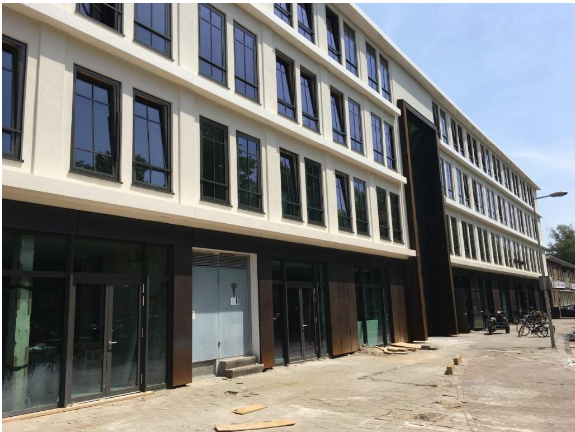
Figuur 3: Een inpandig algemeen voedingspunt in de plint van een gebouw aan de Willem de Zwijgerlaan te Amsterdam
