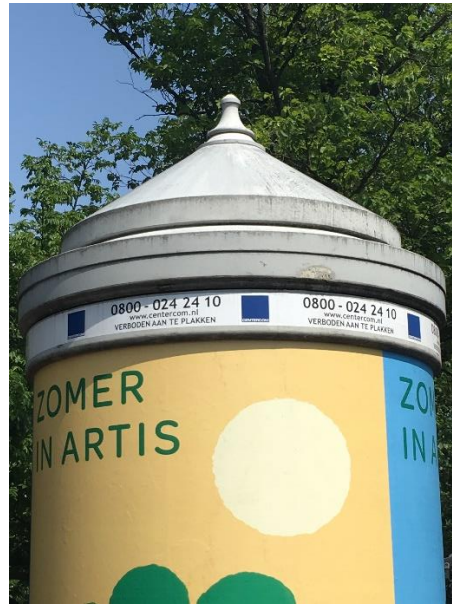
Figuur 33: Alleen langs de toegangsdeur zit een minimale sleuf, de boven- en onderkant hebben geen noemenswaardige ventilatieopeningen
