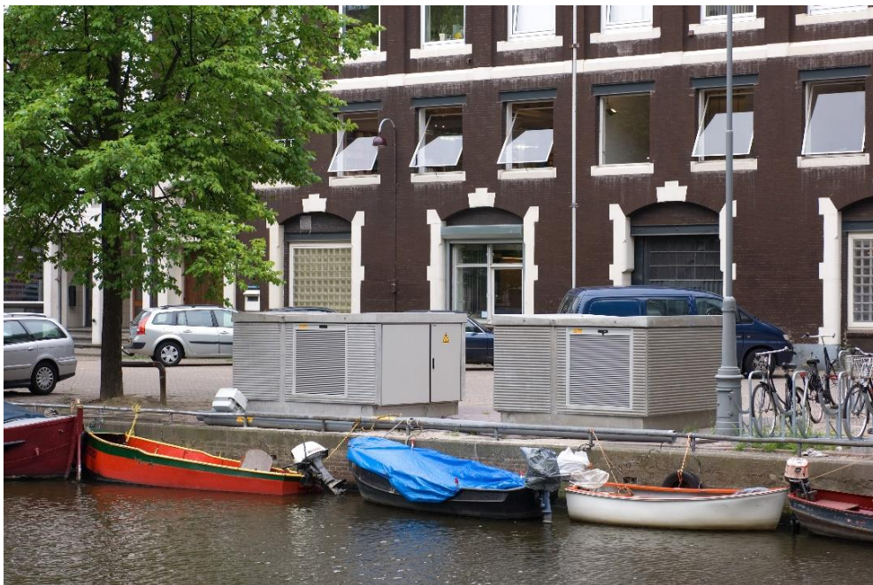
Figuur 2: Een 'laag profiel' algemeen voedingspunt
