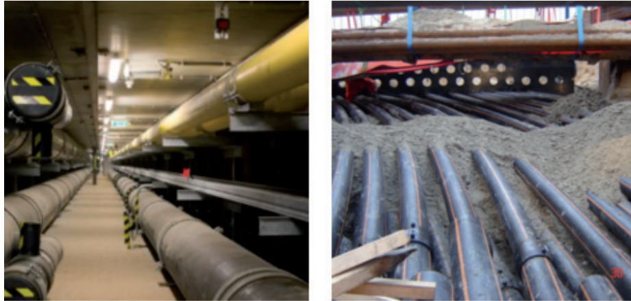
Figuur 8: Kabel en Leidingen tunnel Mahlerlaan en bundeling mantelbuizen Barbara Strozilaan Amsterdam, bron Dienst Zuidas Amsterdam.
