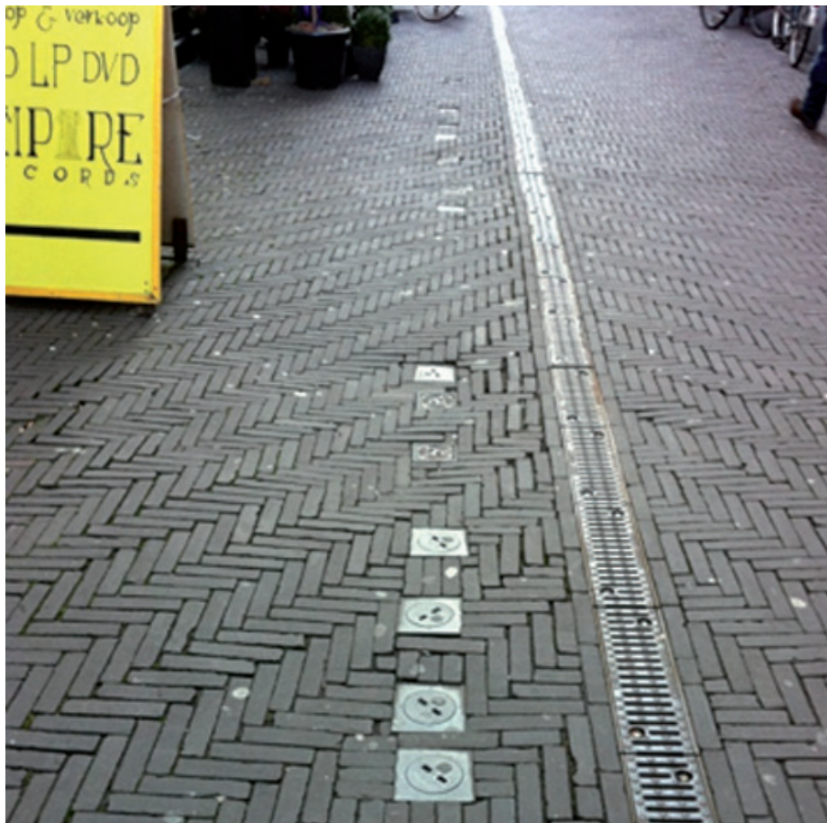
Figuur 7: afsluiterputjes in Korte Houtstraat Den Haag, bron Hompe en Taselaar
