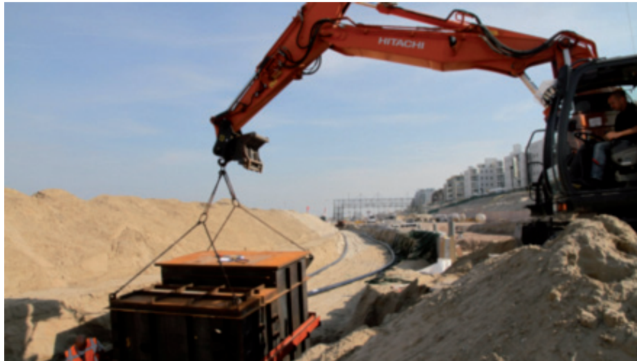
Figuur 9: aanleg mantelbuizen en onderhoudsput, bron www.nieuweboulevardscheveningen.nl
